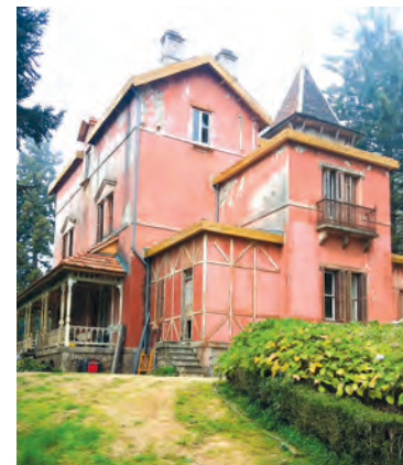
Exemplo de edifício alvo de diagnóstico
